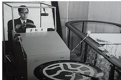
注1：科学技術庁特別研究促進調整費による研究「環境の高速度変化に即応する反射行動の形成プロセスの解明およびその教育方式の確立」の中で開発した訓練シミュレータシステム。コンピュータで学習履歴を記録・管理できる本格的ドライビングシミュレータのプロトタイプであった。
